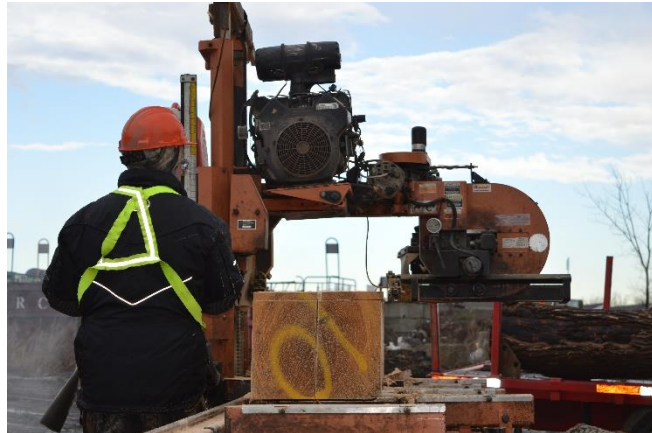
Figure 5: Opération de sciage dans la cour d'entreposage de Longueuil © CQEEE
